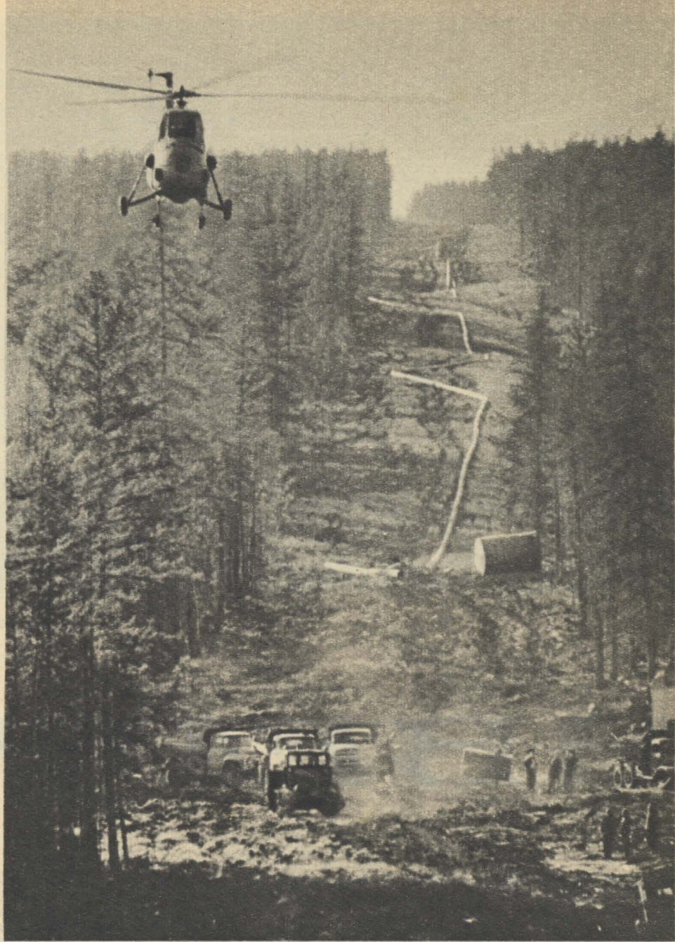
На трассе строящегося газопровода Промышленный — Якутск.
